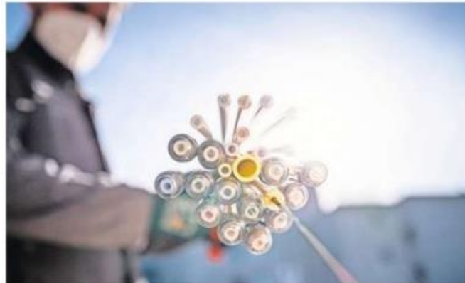
In Bothfeld wird Enercity bis Ende des Jahres rund 30 Kilometer Glasfaserleitungen verlegen. FOTO: ROLAND SCHNEIDER (SYMBOLBILD)
